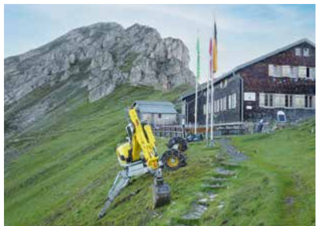
Die Nördlinger Hütte auf 2.238 m hat im Berichtsjahr im Zuge der Verlegung von Ver- und Entsorgungsleitungen den höchstgelegenen Gasanschluss Tirols erhalten.
