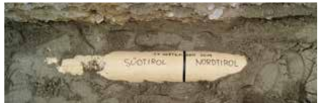
Das Fernheizwerk am Brenner wurde im Berichtsjahr auf Erdgas umgestellt. Ein Jahr zuvor wurde mit der Fertigstellung der Verbindungsleitung am Brennerpass zwischen Süd- und Nordtirol die Basis dafür geschaffen.
