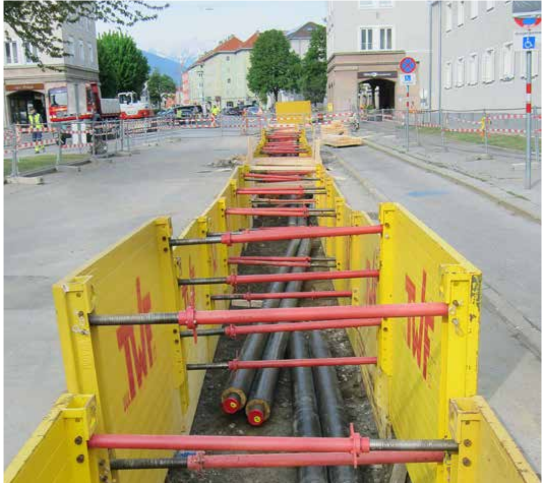
Die TIGAS hat im Geschäftsjahr 2020 das Fernwärmenetz in der Stadt Innsbruck (im Bild: Gumpstraße) weiter verdichtet.
