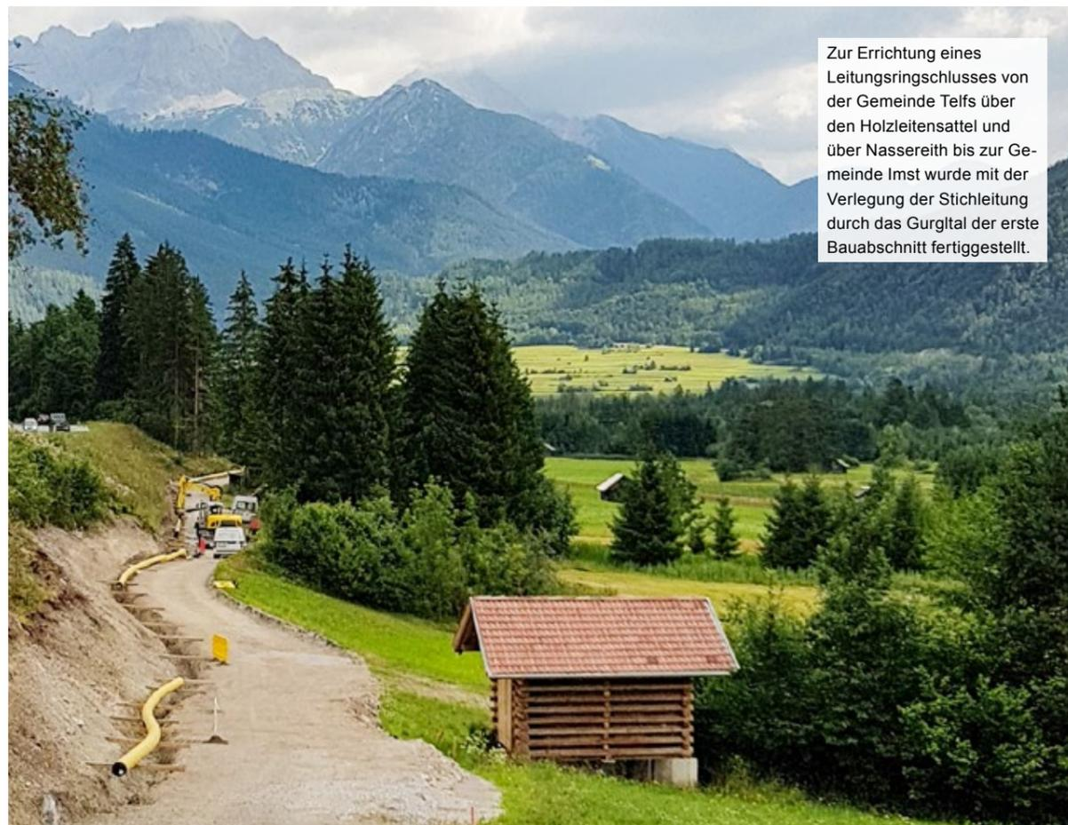
Zur Errichtung eines Leitungsringchlusses von der Gemeinde Telfs über den Holzleitensattel und über Nassereith bis zur Gemeinde Imst wurde mit der Verlegung der Sticheitung durch das Gurgital der erste Bauabschnitt fertiggestellt.
