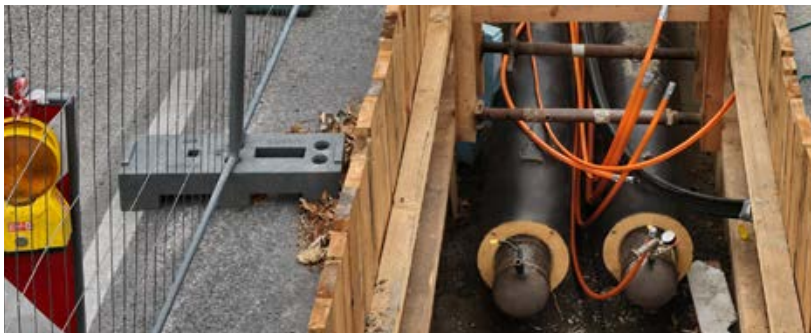
Für den innerstädtischen Lückenschluss in Innsbruck wurde die Fernwärmetransportschiene von der Kreuzung Innrain / Anichstraße bis zur Rechengasse verlängert.
